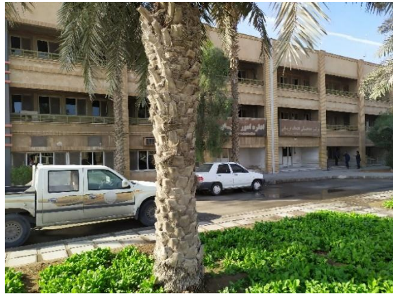
شکل ۶- نمایی از ساختمان سه طبقه مورد مطالعه
