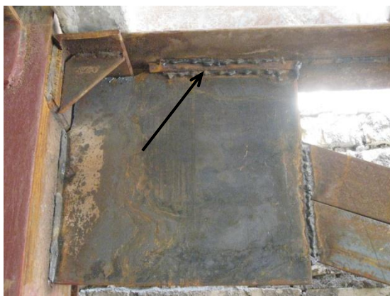
شکل (۲): کارگذاری میلگرد در ریشه جوش صفحه با تیر
