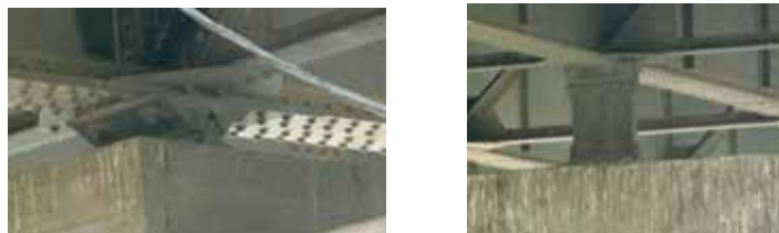
شکل (۵): تکیه‌گاه‌های پل فلزی؛ سمت راست تکیه‌گاه نوع ۱، سمت چپ تکیه‌گاه نوع ۲.
