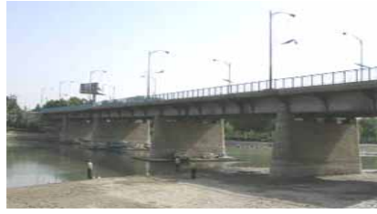
ب. نمای غربی پل
