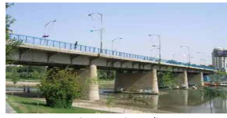
الف. نمای شرقی پل
