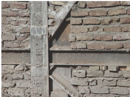
شکل (۱): اتصال مهاربندی هم‌مرکز
