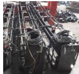
(پ) نصب کرنش سنج
