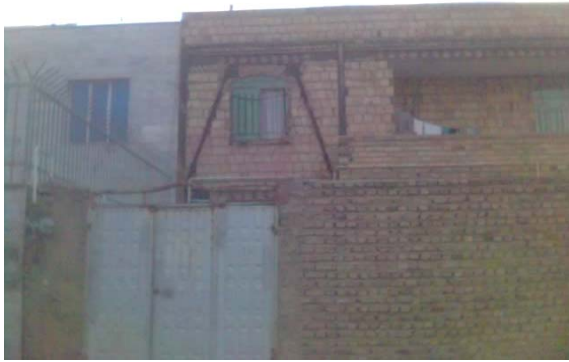
شکل (۱): استفاده از مقاطع لانه زنبوری در سازه های با مهاربندی برون محور ساخته شده و در حال ساخت [۹]
