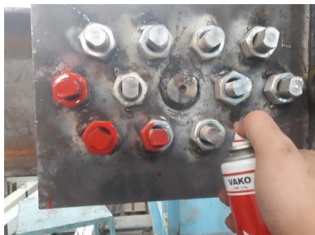
شکل ۲۶- رنگ آمیزی مهره و ابتدای ناحیه رزوه شده میراگر
