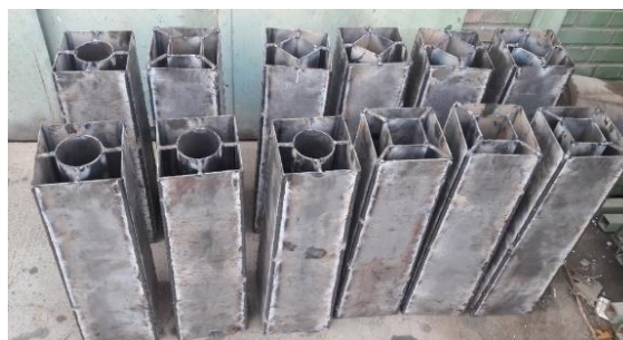
شکل ۲- ستون‌های ساخته شده قبل از بتن ریزی
