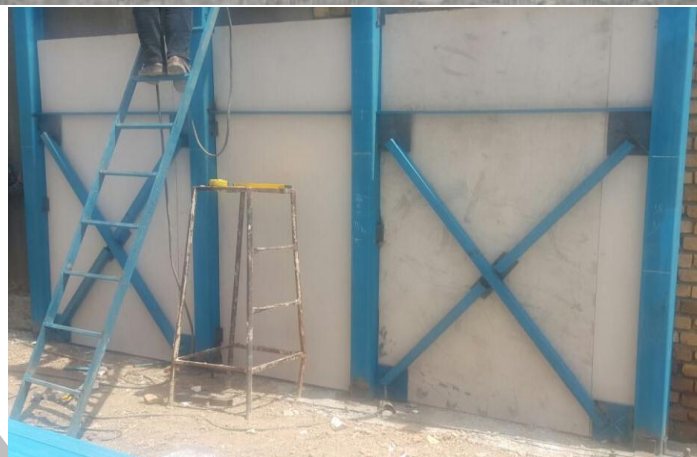
شکل ۲- جوشکاری ستون‌ها و تیرهای رابط بین آن‌ها در محل و اجرای قاب ساخته شده بر روی فنداسیون
