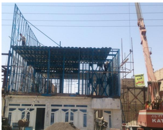
شکل ۶- اضافه نمودن طبقات بیشتر به ساختمان ساخته شده
