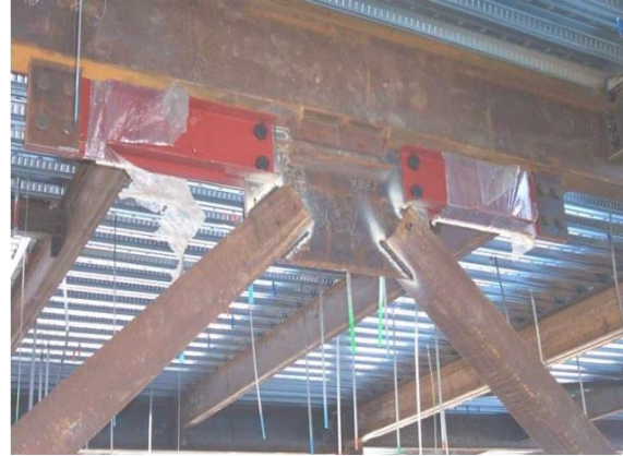
شکل ۴- میراگر اصطکاکی پال
