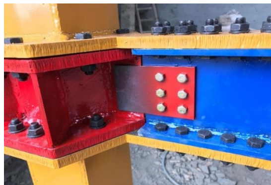
شکل ۳- ماکت اجزا اتصال برای حالت اتصال شش تیر به ستون قوطی در این پژوهش، نخست، نمونه‌ی آزمایشگاهی اتصال Liu و
