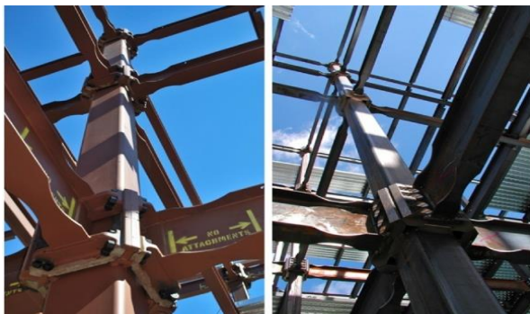
شکل ۱- نمایی از اتصال ConXL
