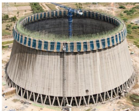
شکل ۴- برج خنک‌کننده با ستون‌های بتنی A شکل
