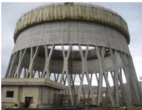
شکل ۳- برج خنک‌کننده با ستون‌های بتنی X شکل
