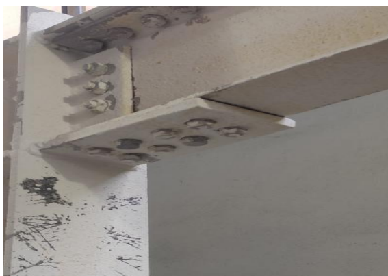
شکل ۶- تشکیل مفصل پلاستیک در ستون در قاب BFP
