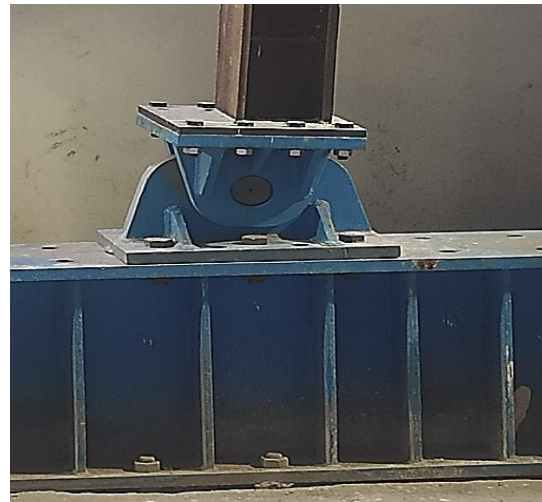
شکل ۲- اتصال کاملاً مفصلی پای ستون
