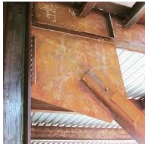
شکل ۱- اتصال مهاربند به تیر و ستون با ورق گاست
