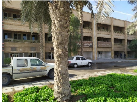
شکل ۶- نمایی از ساختمان سه‌طبقه مورد مطالعه
