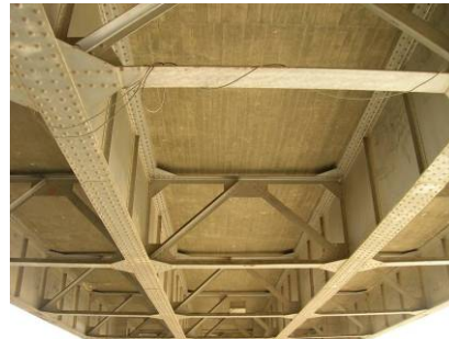
شکل (۲): شکل و ابعاد شاهتیرهای پل مورد مطالعه و دیافراگم‌های جانبی عرشه
