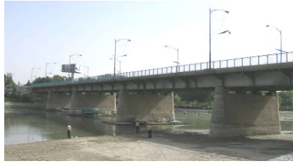
ب. نمای غربی پل
