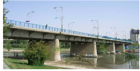
الف. نمای شرقی پل
