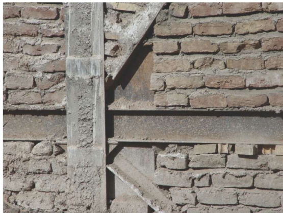
شکل (۱): اتصال مهاربندی هم‌مرکز
