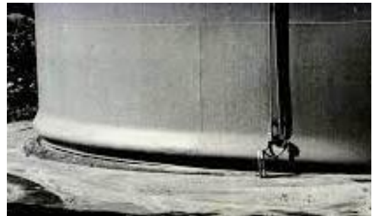
شکل ۱- کماتش پافیلی پوسته مخزن فولادی [۳]
