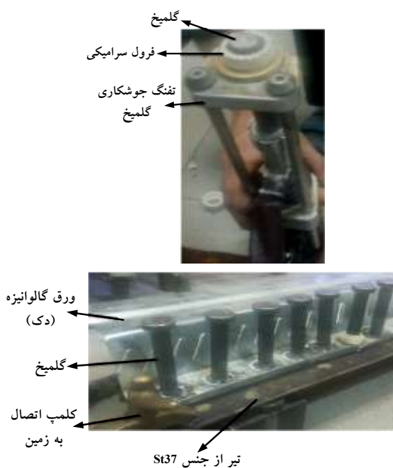
شکل (۳): مصالح مربوط به جوشکاری گلمیخ انجام شده
