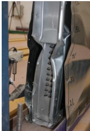
شکل ۸- کمانش موضعی ستونک کناری، بیرون آمدگی پیچ و جدا شدگی پوشش از قاب فولادی
