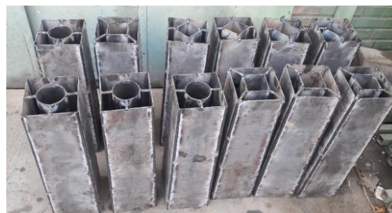
شکل ۲- ستون‌های ساخته شده قبل از بتن ریزی
