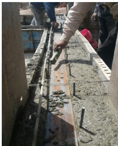
شکل ۱- نحوه ی اجرای فنداسیون و لاوک تحتانی بر روی آن
