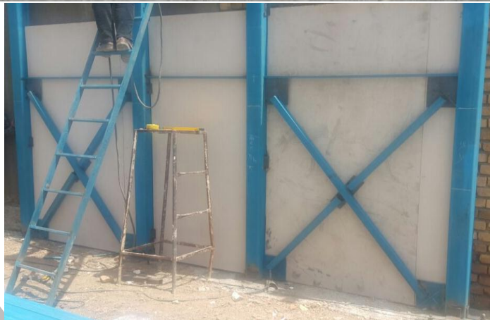
شکل ۲- جوشکاری ستون‌ها و تیرهای رابط بین آن‌ها در محل و اجرای قاب ساخته شده بر روی فنداسیون
