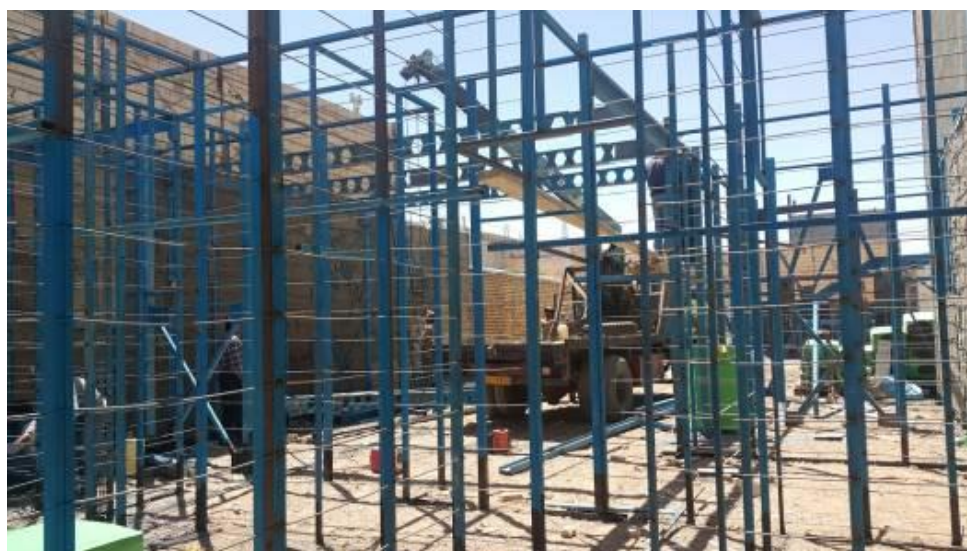
شکل ۳- اجرای تیرهای اصلی پس از نصب قاب‌های ساختمانی
