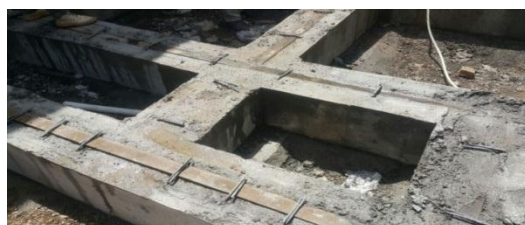
شکل ۱- نحوه ی اجرای فنداسیون و لاوک تحتانی بر روی آن
