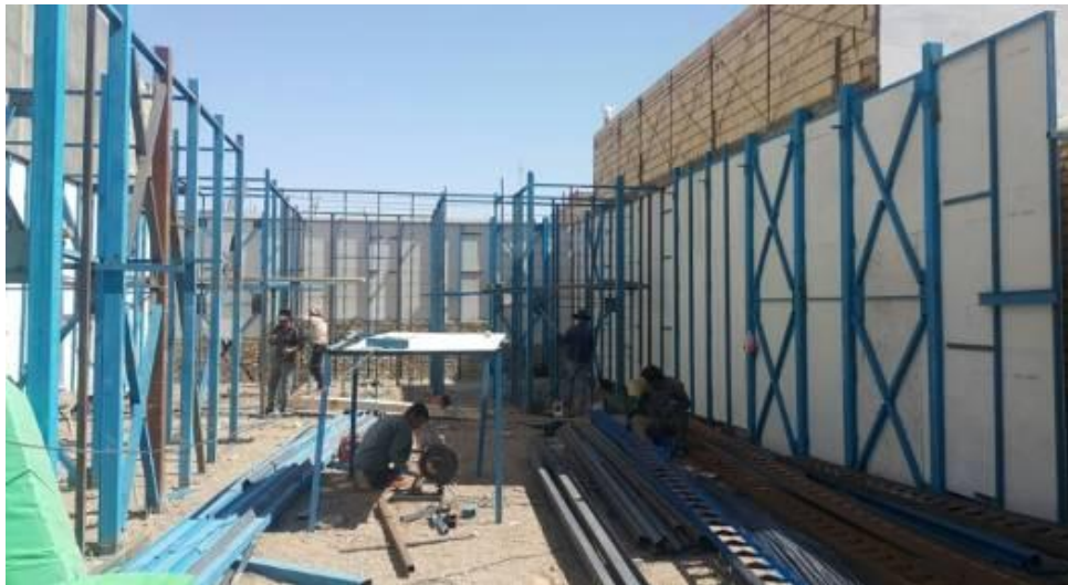
شکل ۴- اجرای دیوارهای خارجی
