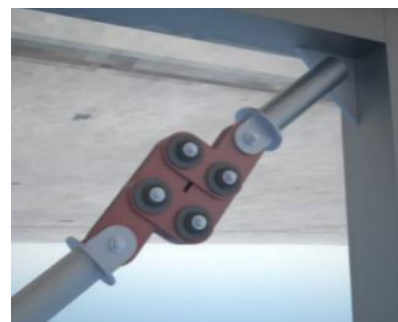
شکل ۱۵- نحوه قرارگیری میراگر نوع اول در قاب مهاربندی y
