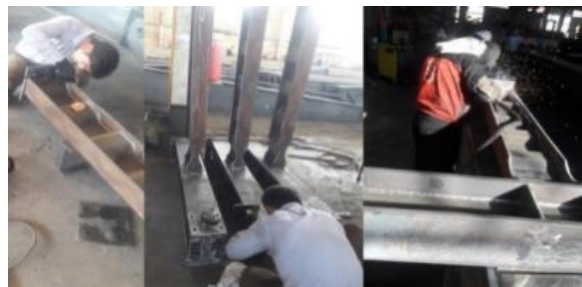
شکل ۴- نمونه اتصال ساخته شده جهت آزمایش
